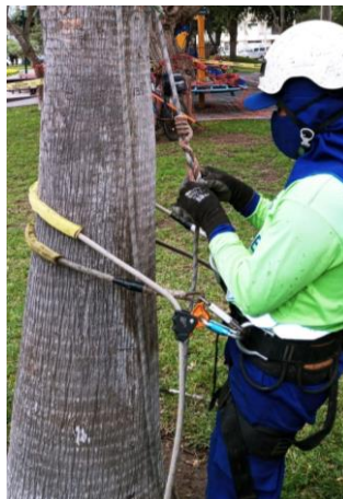
Instalación de Salvarama y Sistema de Cuerda Móvil - MRS
